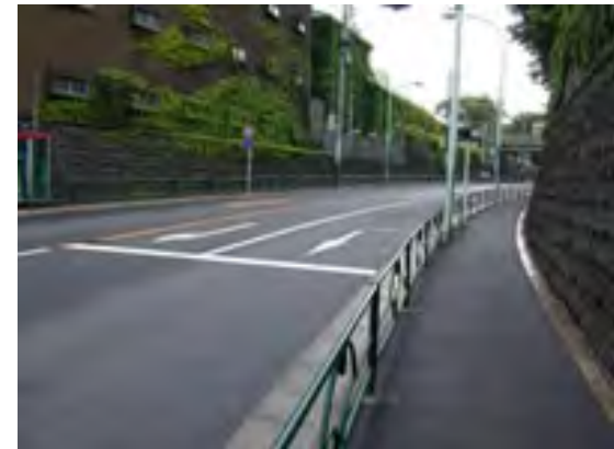
Road using melting slag
